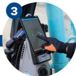
3 施工開始！ 刃先位置をガイダンス
