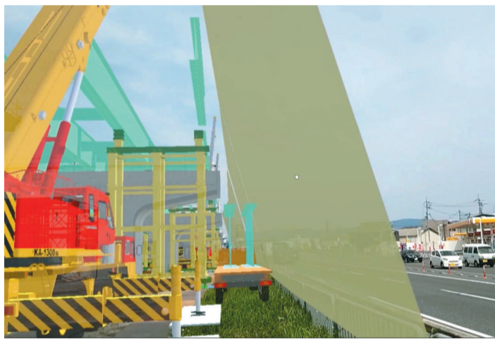
作業俯角の投影による道路利用者の安全確保
