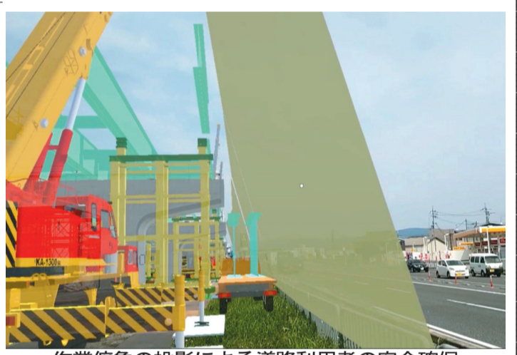
作業俯角の投影による道路利用者の安全確保
