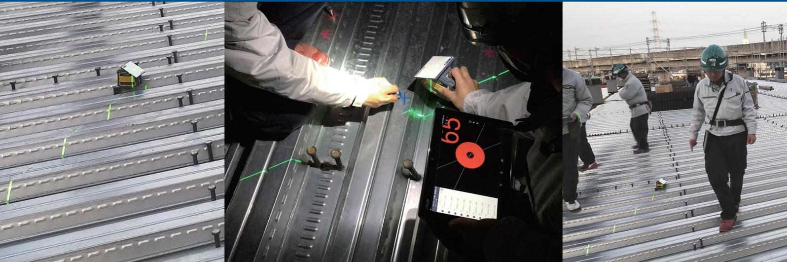
あらゆる産業でデジタルトランスフォーメーション(DX)による業務改革が進んでいる昨今、労働者不足で効率化が求められる建築業界でもワンマンの墨出しソリューションに関心が寄せられています。タブレット端末上の墨出しポイントをタップするだけで2本のレーザーラインがクロスしてポイントを誘導する「QML800G-XT」で作業効率の向上を推進する株式会社朝日工業社 技術研究所の水野様と東関東支店技術部の稲葉様にその効果を伺いました。
