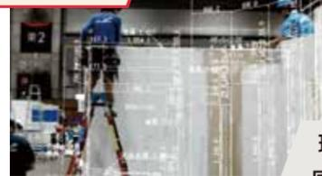
現場で設計情報を原寸表示 (2D 図面や 3D モデル)
